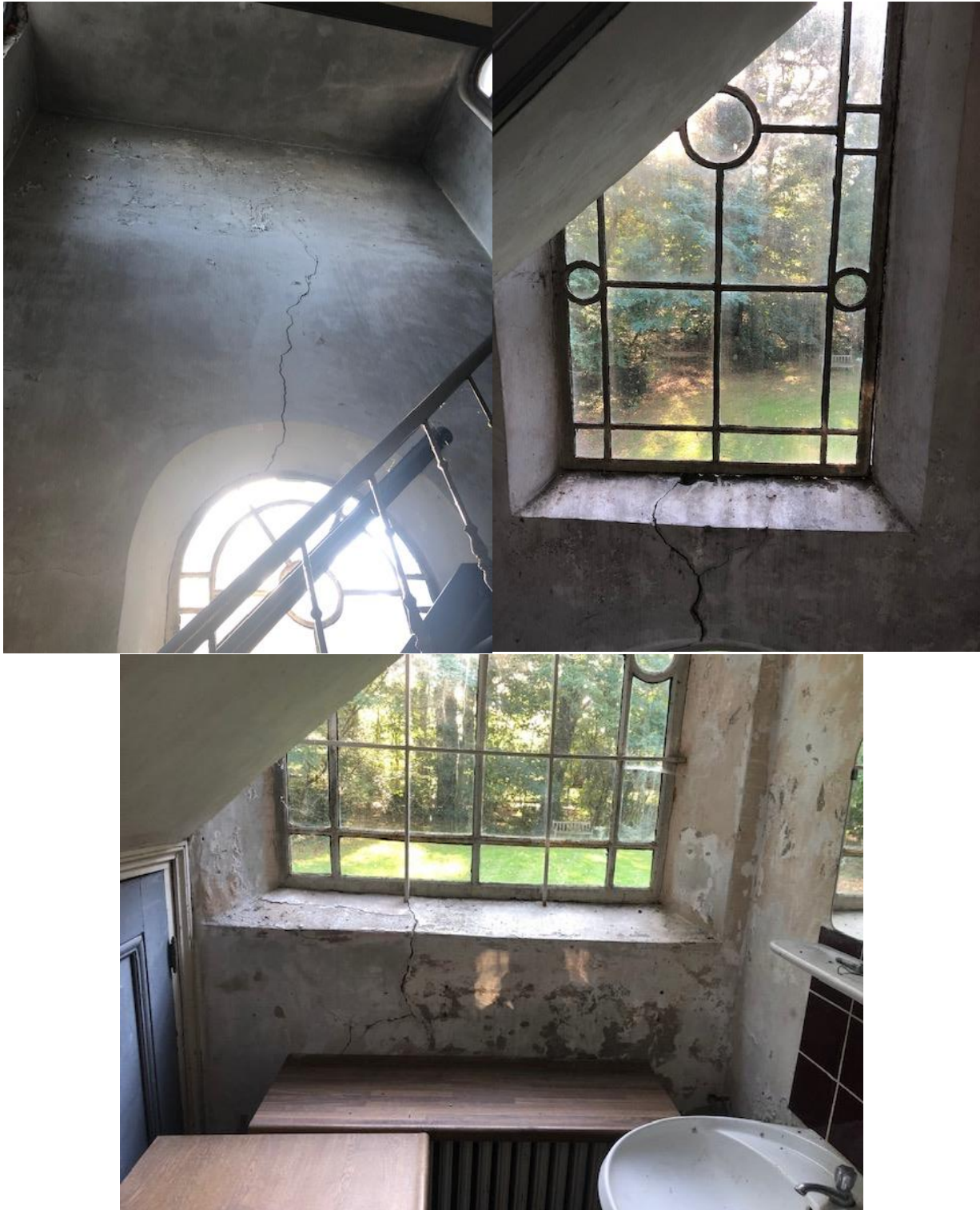
Binnenmuur westkant van de toren.
